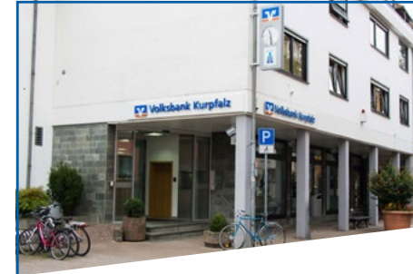
Filiale Ziegelhausen Kleingemünder Str. 33, 69118 Heidelberg
